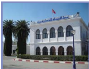
Bâtiment du gestionnaire
