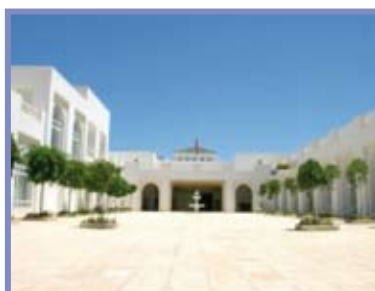
Centre de vie
