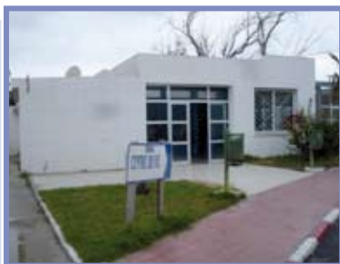
Centre de vie
